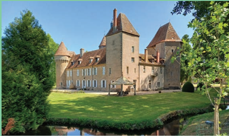
Le Château de la Motte-Feuilly vu du sud-ouest
